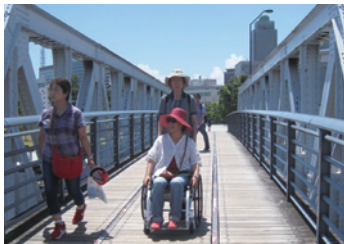
〈新港橋梁〉は、1912（大正元）年に建造。旧横浜駅（現桜木町駅）から延びる貨物線の鉄道橋（横浜臨港線）。
