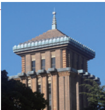
〈神奈川県庁本庁舎〉の愛称は「キング」。関東大震災で焼失後、1928（昭和3）年10月31日に再建。
